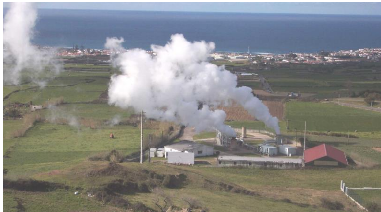
Figura 2 – Central Geotérmica Piloto do Pico Vermelho (3MW)
