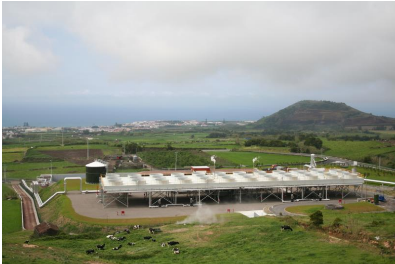
Figura 3 – Central Geotérmica Piloto do Pico Vermelho (10MW) - 2007
