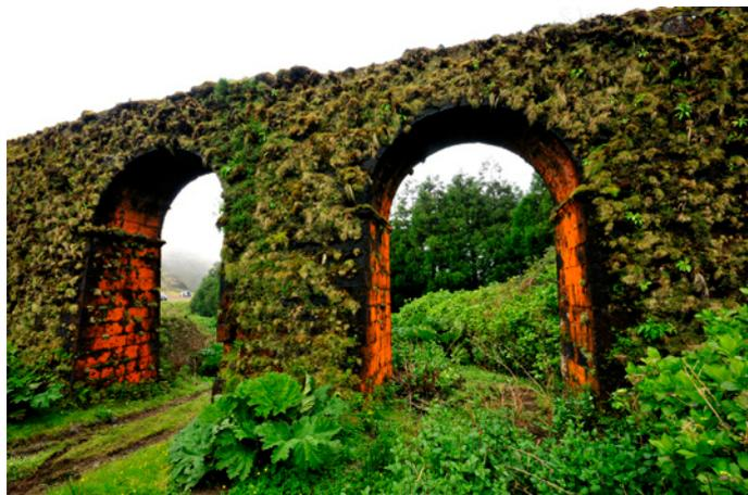
Este aqueduto integra ainda o Muro do Carvão, um troço em alvenaria de pedra, composto por diversos arcos de volta perfeita e com uma extensão de aproximadamente 150 m, que se situa junto ao pico com o mesmo nome. Nos extremos do muro existem duas câmaras repartidoras de caudal, conhecidas como “arquinhas”.
