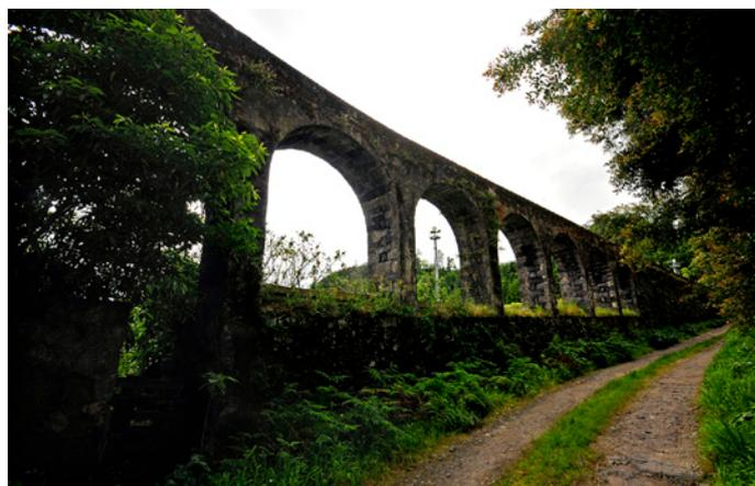
Devido à fragilidade das condutas de barro, frequentemente furadas pelas raízes das árvores, criando no seu interior as chamadas “raposas”, procedeu-se à substituição dessas condutas por outras em ferro fundido dúctil. Essas adutoras, também em escoamento sob pressão, permitiam assegurar pressões superiores e resistir à invasão das raposas.
