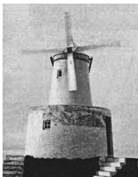
Fig. 84 – 1963 Terceira, Raminho, Presa Grande. Moinho de torre do tipo da Terceira, adaptado para de carácter mecânico.
