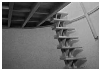
Fig.114 Escada de acesso ao piso superior.
