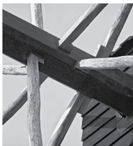
Fig. 53 – 2006 Mar. Encaixe dos varais no mastro.
