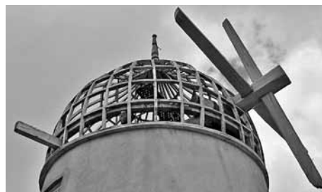
Fig. 17 – 2006 Jan. Graciosa, Praia São Mateus, Arrochela. Cúpula em construção, com estrutura aparente e mastro com cruzetas para receber o velame.
