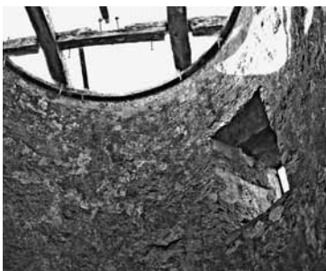
Fig. 26 – 2005 Set. São Jorge, Ribeira D' Areia. Frechal de pedra com rebordo interior para rodado horizontal.
