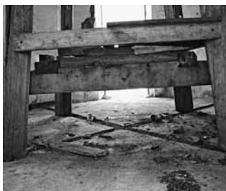
Fig. 94 – 2005 Mai. Terceira, Biscoitos, Mistério. Apoio da moenda em madeira, em estado de ruína.
