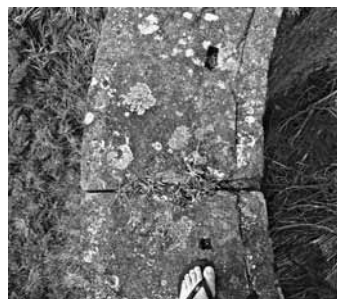
Fig. 35 – 2004 Ago. Frechal das paredes em pedra aparelhada, com (entalhes para frechal de madeira que apoiava o rodado vertical da cúpula).
