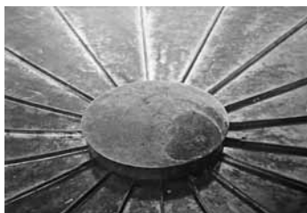
Fig.113 Cobertura em cobre.
