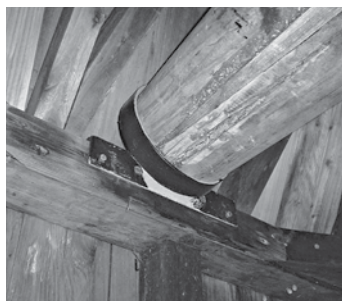
Fig. 55 – 2004 Dez. Engate do espigão do mastro com a concha.
