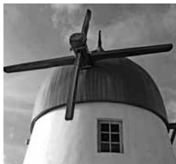
Fig.116 – 2006 Jan. Mastro curto com cruzetas.
