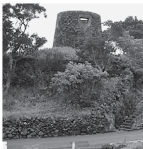
Fig. 37 – 2006 Abr. Vista do lado oposto da estrada.
