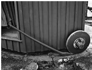
Fig. 79 – 2005 Set. Alavanca manual que acciona a rotação do moinho.
