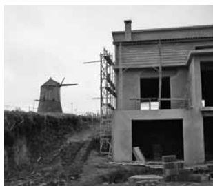
Fig. 129 – 2006 Jan. Faial, Feteira, Rua das Courelas Moradia em construção a cerca de 15m.
