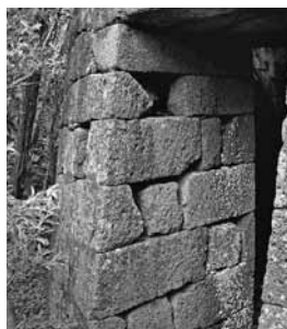
Fig. 28 – 2005 Ago. Tronco-cone em pedra aparelhada.
