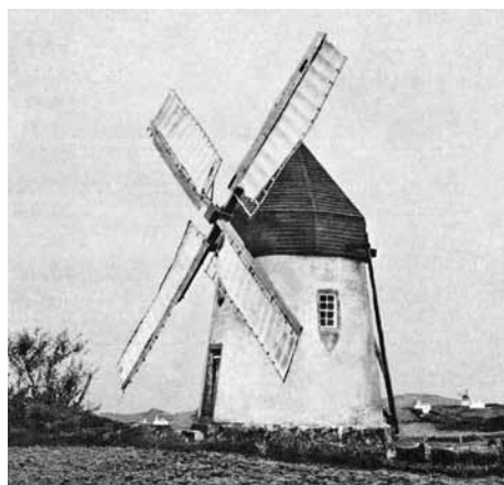
Fig. 18 – 1963 Santa Maria, Vila do Porto, Santo Espírito. Cúpula octogonal (ou piramidal de secção octogonal).
