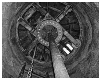
Fig. 92 – 2005 Set. São Jorge, Topo, Engenho. Interior do tronco-cone superior em betão.
