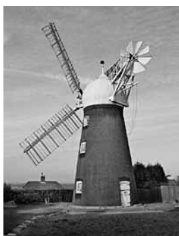
Fig. 5 Moinho na Inglaterra Elli's Mill, Lincoln, Inglaterra. Construído em 1798, reformado em 1977.
