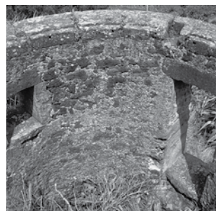
Fig. 38 – 2004 Ago. Vãos e frechal, em pedra aparelhada.
