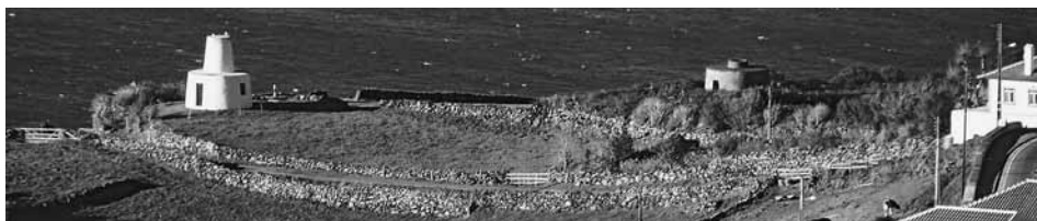
Fig. 86 – 2005 Dez. Terceira, Serreta, Canada do Alves. Moinhos adaptados para o tipo de carácter mecânico, já sem madeiramentos.
