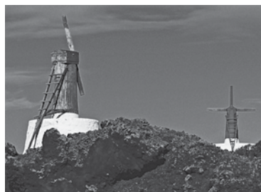
Fig. 98 – 2005 Set. Velames de duas e quatro pás.
