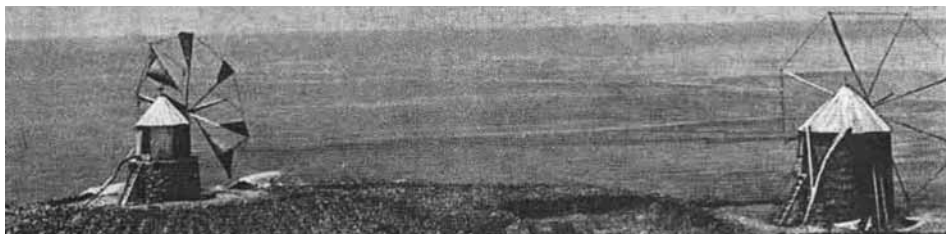
Fig. 85 – aproximadamente 1950 Terceira, Serreta, Canada do Alves. Moinho giratório de madeira e moinho fixo de pedra ou de torre.
