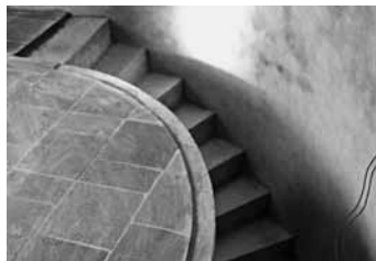
Fig.118 – 2006 Jan. Escada de acesso do piso 0 ao piso 1.
