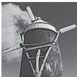
Fig.101 – 2005 Set. Troncocone superior em betão.
